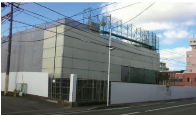
建設中の復興公営住宅(宮城野・幸町第三)
