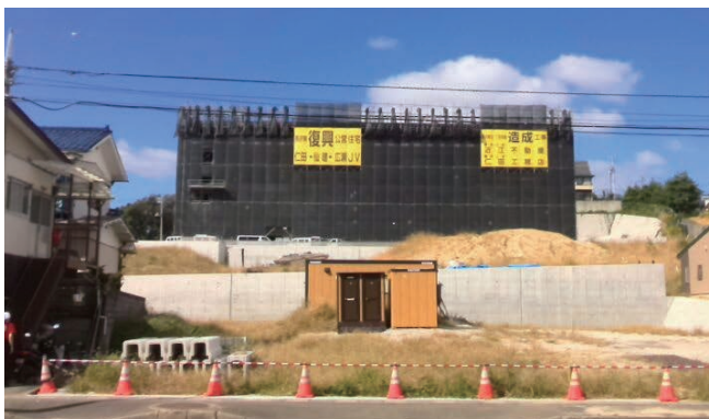
建設中の復興公営住宅(燕沢東)
