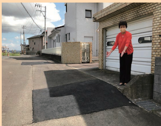
道路の段差解消(燕沢地区)
