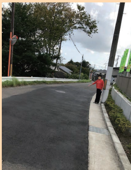
車道の整備(西山地区)
