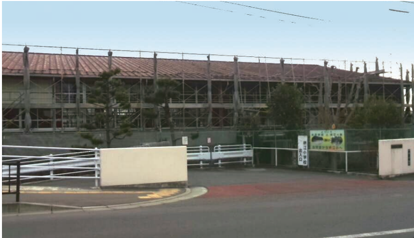
栞江小学校体育館の屋根改修工事が、いよいよ始まりました。老朽化や震災の影響により雨漏りがする状況でした。地域からの強い要望を受け「災害時には避難所となる小学校の体育館の修繕を速やかに実施せよ」と訴え、工事が始まりました。(12月)
