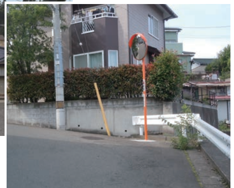
カーブミラーの設置 (燕沢に2基設置)
